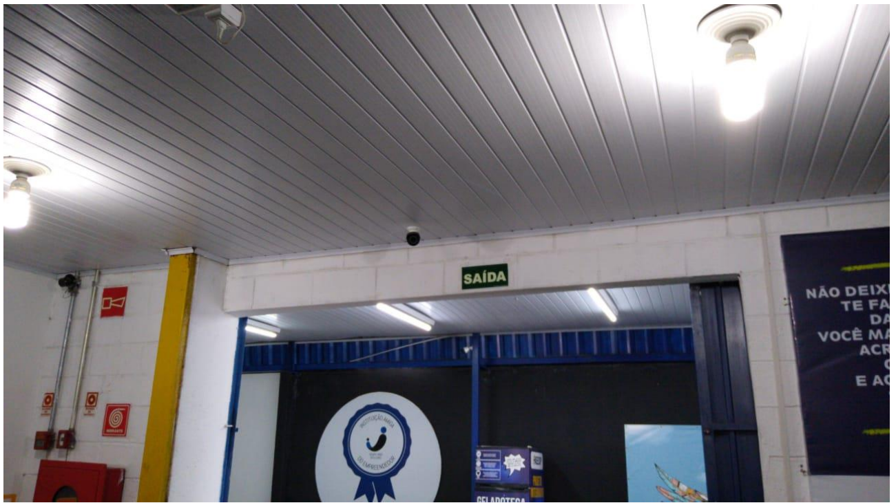
Imagem 5: Instalação de Câmeras.. Foto tirada em: 02/03/2020. Acervo da Instituição.
