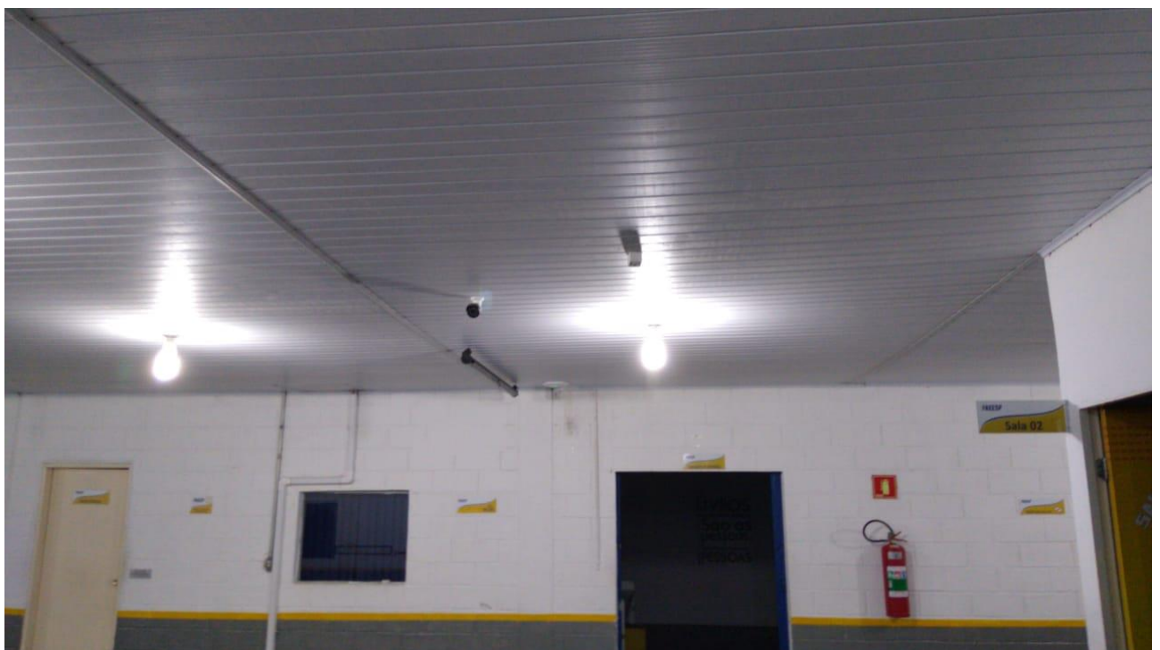
Imagem 6: Instalação de Câmeras.. Foto tirada em: 02/03/2020. Acervo da Instituição.
