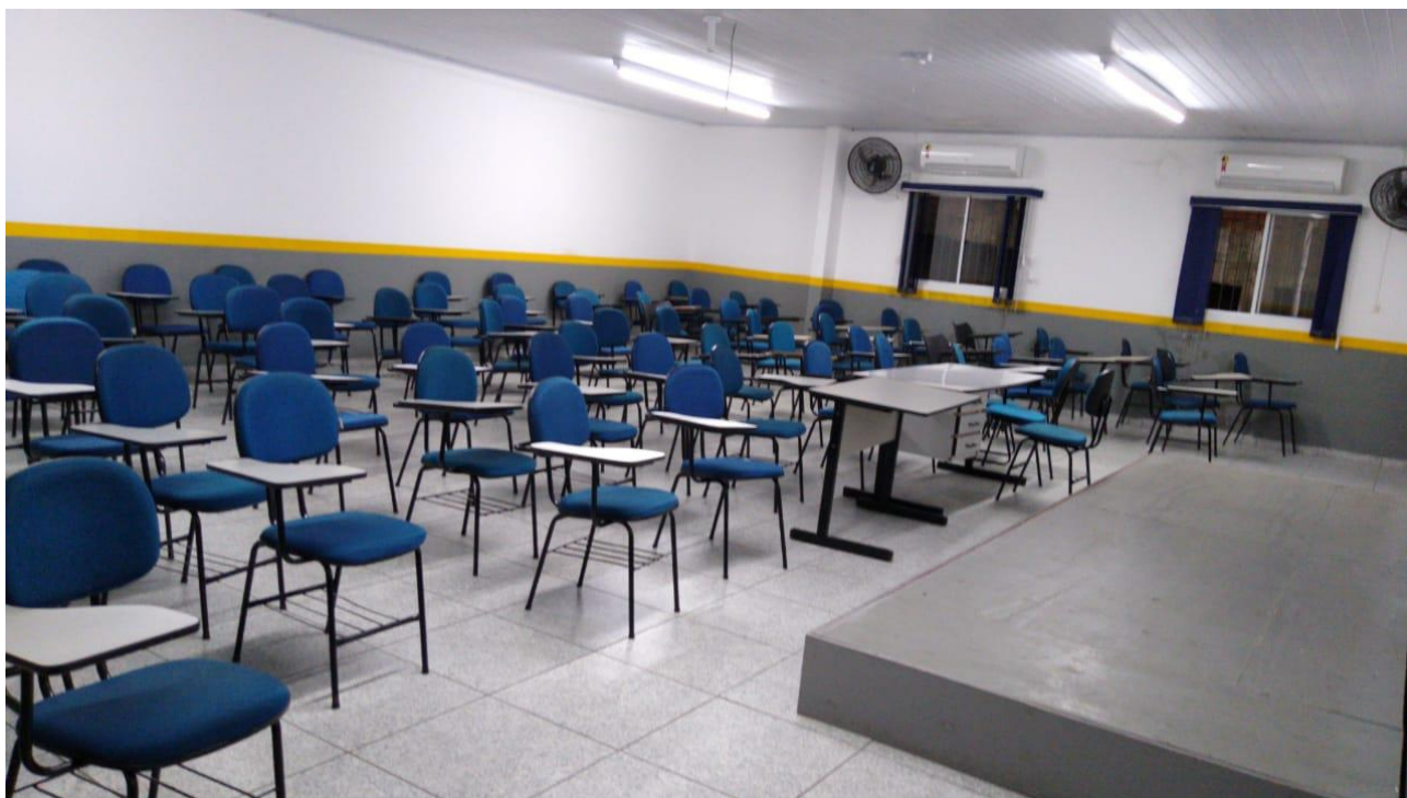
Imagem 6: Reforma na instalação de iluminação e paredes.. Foto tirada em: 02/03/2020. Acervo da Instituição.
