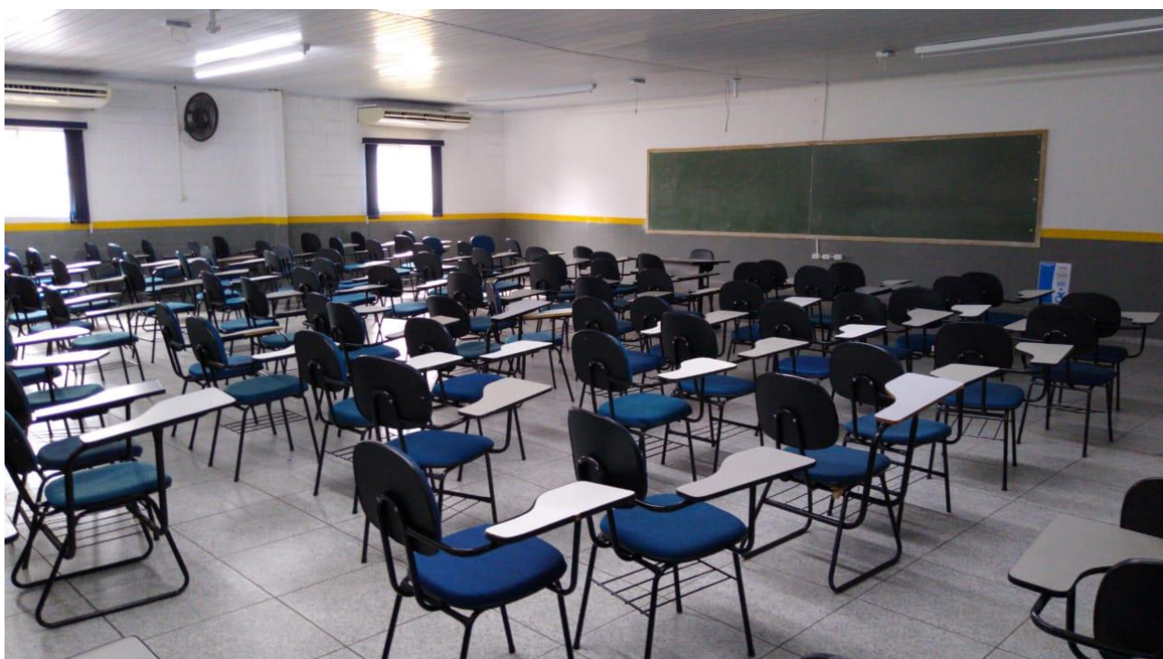
Imagem 7: Reforma na instalação de iluminação e paredes.. Foto tirada em: 02/03/2020. Acervo da Instituição.
