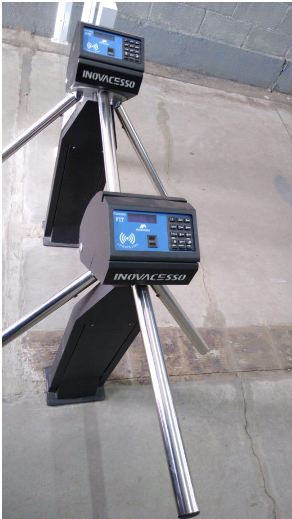
Imagem 4: Instalação de Catracas na Entrada do prédio. Foto tirada em: 02/03/2020. Acervo da Instituição.
