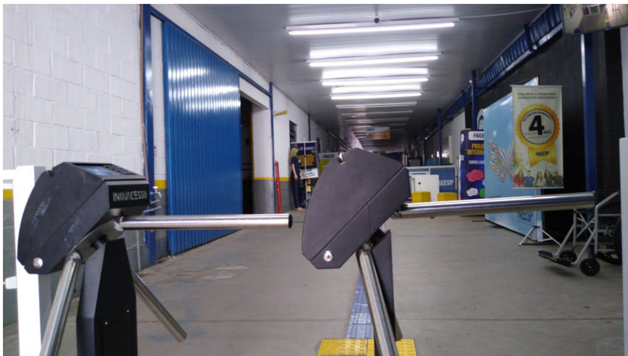
Imagem 1: Instalação de Catracas na Entrada do prédio. Foto tirada em: 02/03/2020. Acervo da Instituição.
